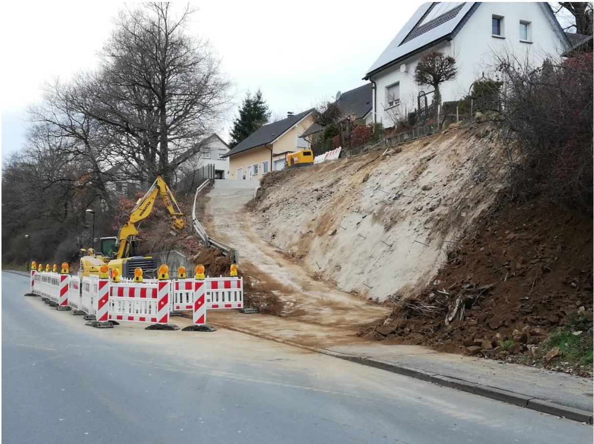
Foto 2: Böschungssicherung Settmeckestraße (bislang noch ohne Stahlnetz)
