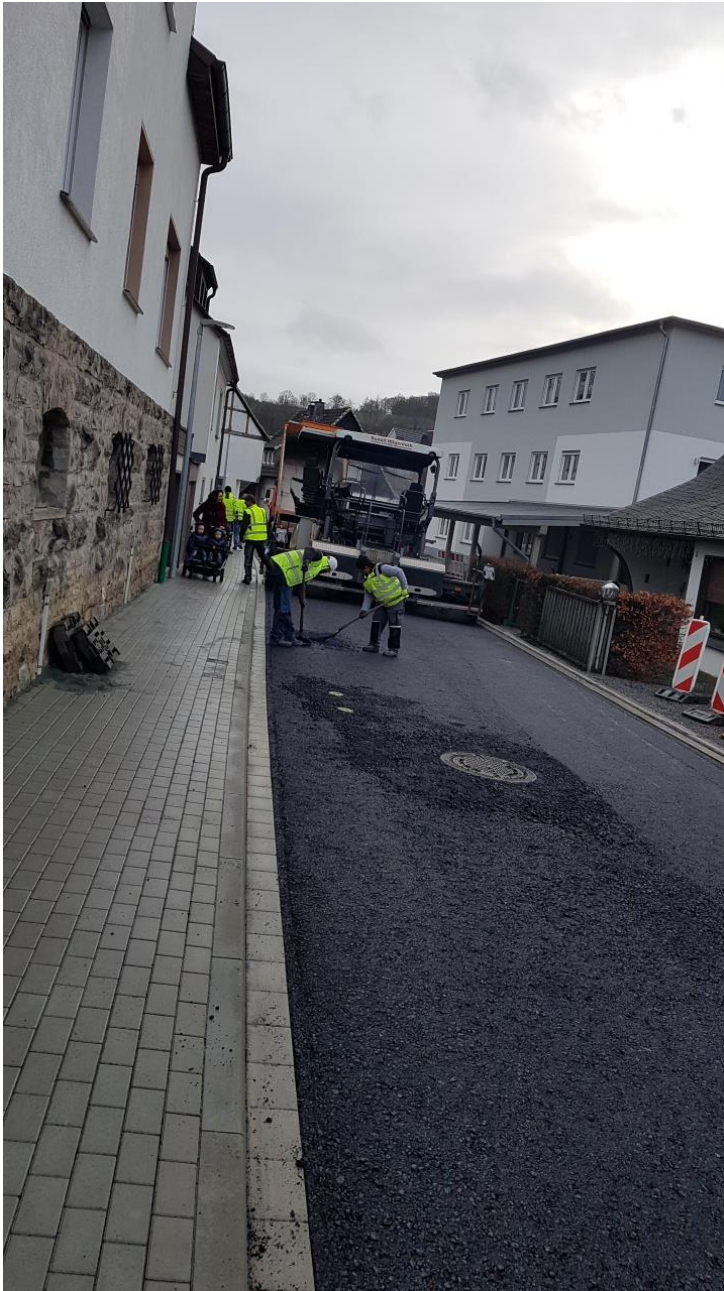
Foto 1: Asphaltierungsarbeiten im Buchweg in Sundern
